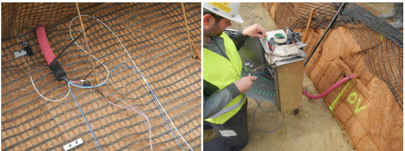
Figure 19. Protection des câbles de mesure au niveau du recouvrement du remblai et connexion à l'armoire de mesure permanente. Source : CSTC.
