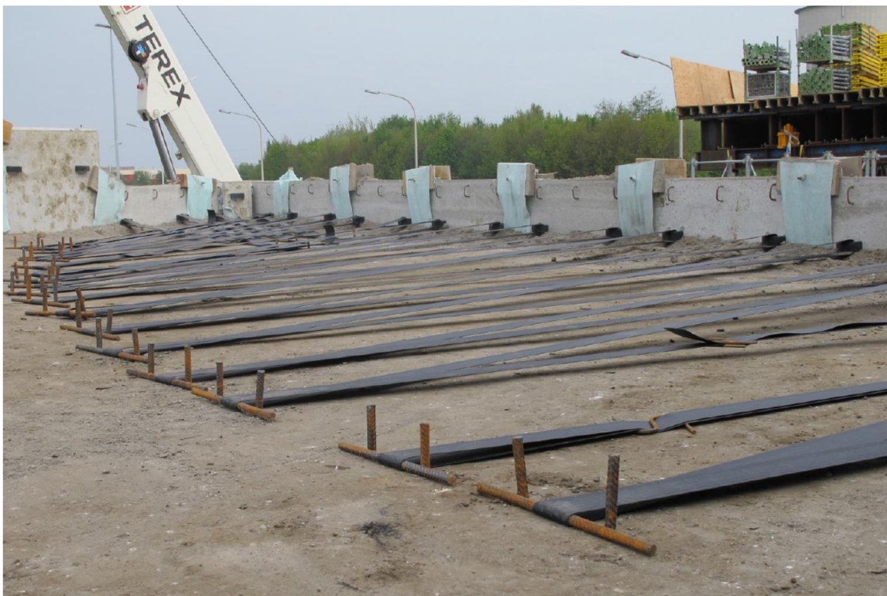
Figure 3. Exemple d'application en Belgique (3) : Remblai renforcé au moyen de bandes en polyester connectées à des panneaux en béton préfabriqués. Source : Texion et Maccaferri.
