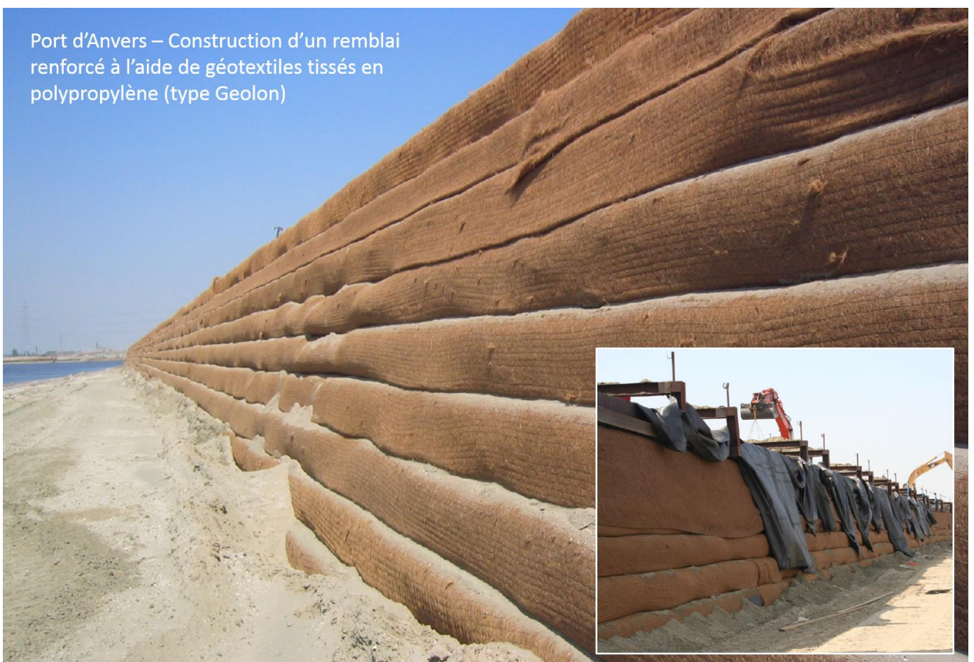
Figure 1. Exemple d'application en Belgique (1) : Remblais renforcés au moyen de géotextiles tissés. Source : Texion et TenCate.
