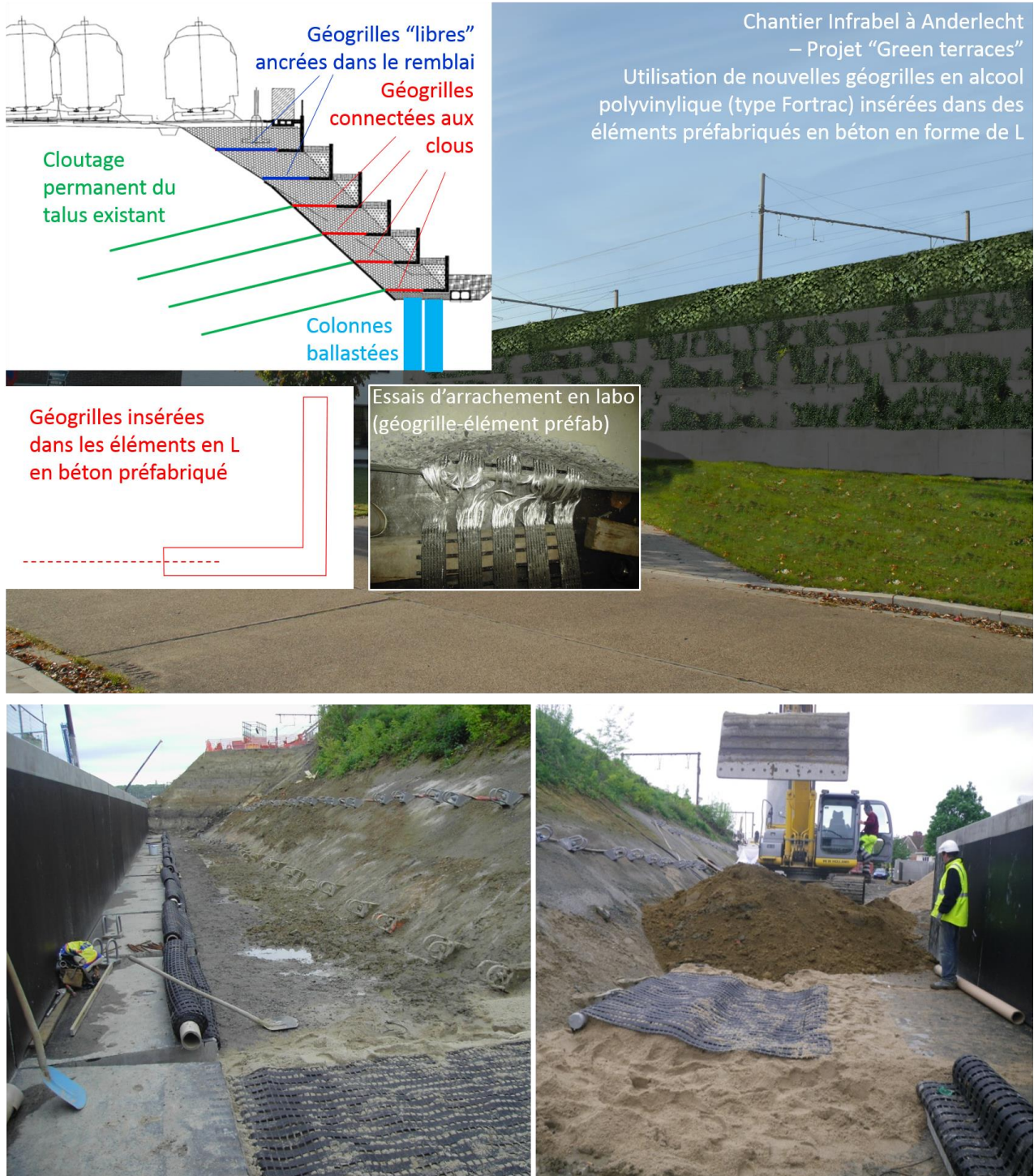
Figure 4. Exemple d'application en Belgique (4) : Remblai renforcé au moyen de géogrilles insérées dans des éléments préfabriqués en béton en forme de L.
